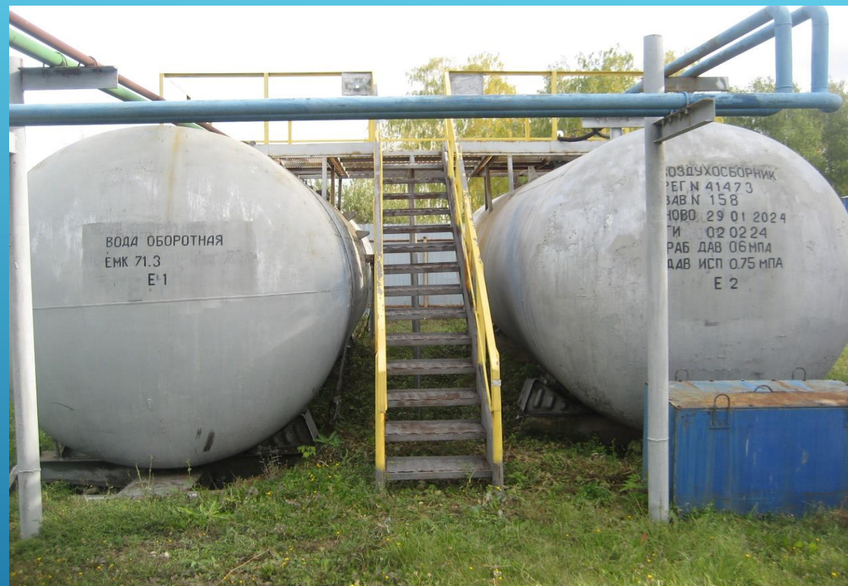
Резервуар оборотной воды Емкость 54 куб.
