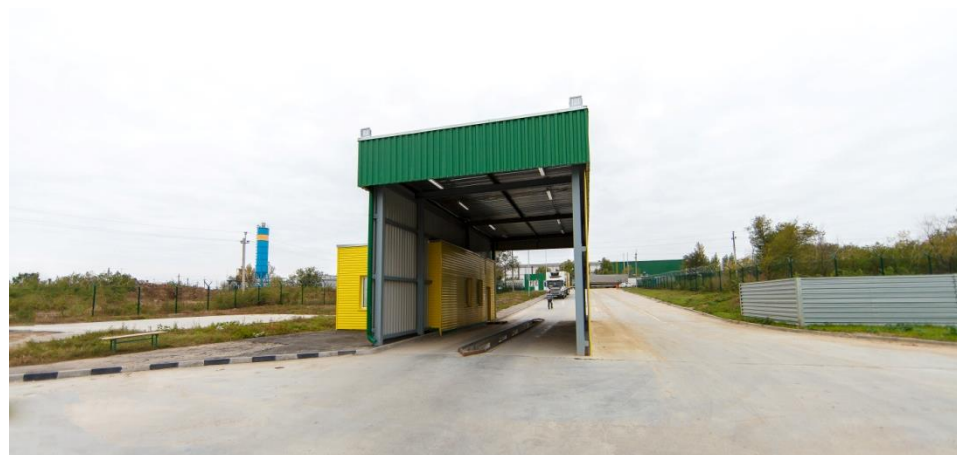
Топливо-заправочный пункт для дизельного топлива объёмом 50 м3, 2 колонки по 2 пистолета в каждой.
