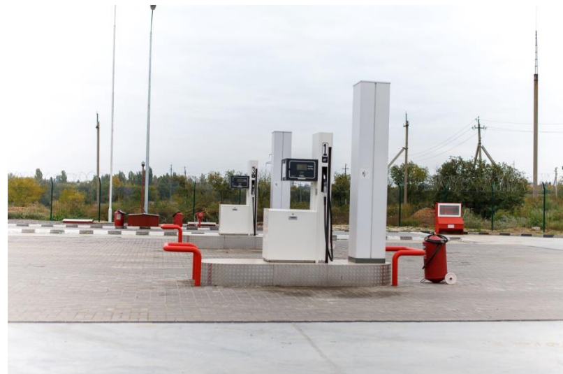
Топливо-заправочный пункт для дизельного топлива объёмом 50 м3, 2 колонки по 2 пистолета в каждой.
