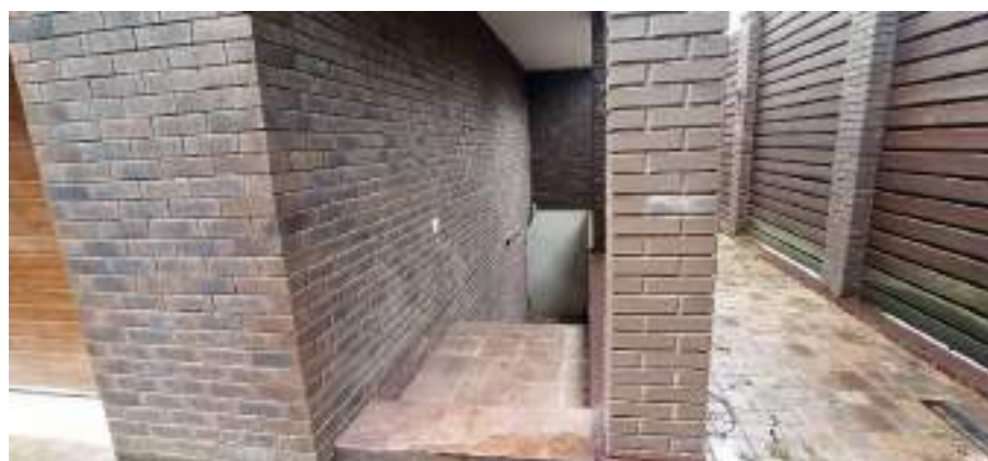
Внешний вид жилого дома
